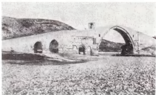
106. Pod peste Batman Su. (Foto J. Sawvaget.)
