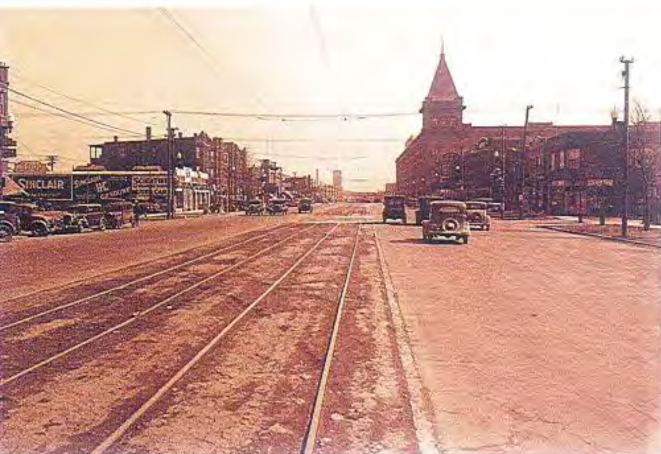
▲ Cicero, la vremea când Capone și-a mutat sediul central aici. Asemenea orașului Chicago, este amplasat în Cook County, în statul Illinois. Era cunoscut drept sediul fabricii Western Electric
